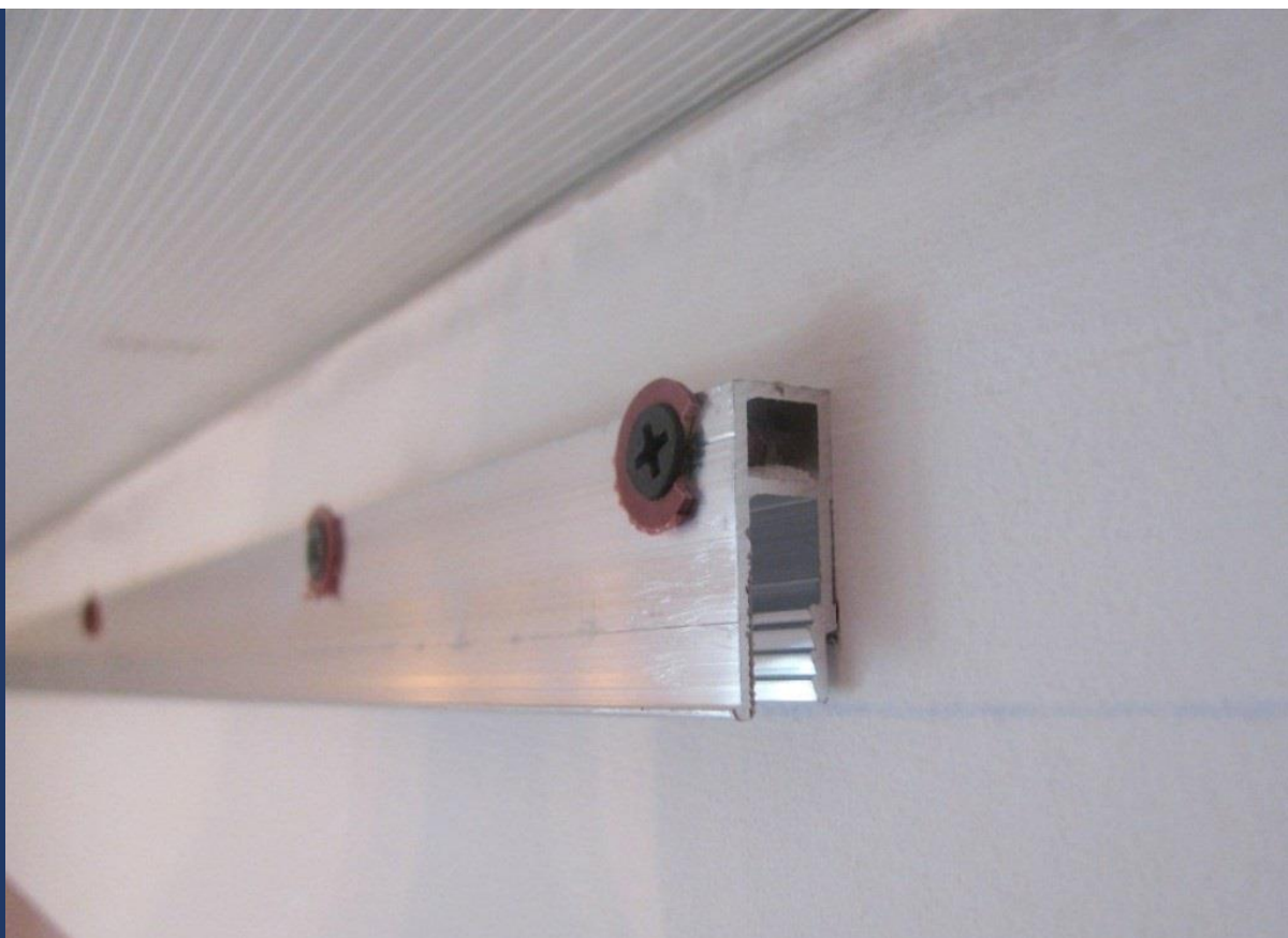
Крепление профиля для натяжного потолка
